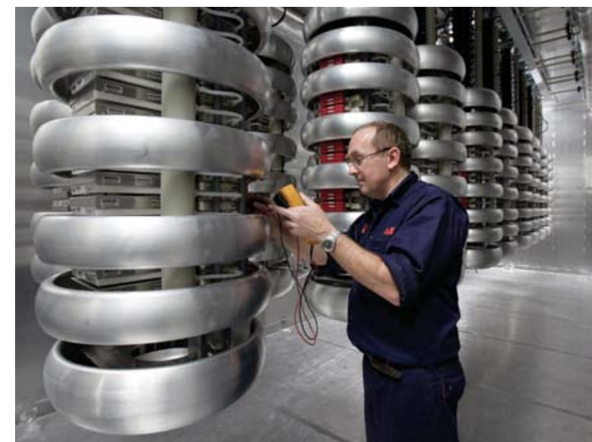
图5: ABB 公司的工程师在德国北部远程海上风力发电场测试一个 HVDC Light 阀。
